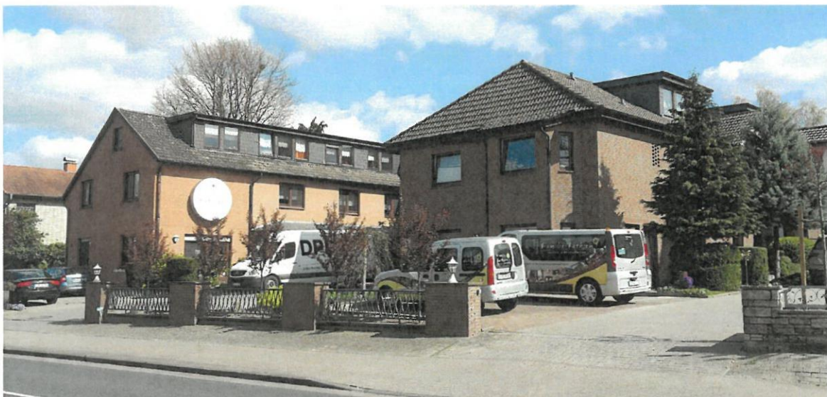
Nördliche Grundstückssituation, an der Straße Am Triften
